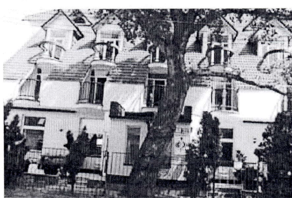
Budova Domova sv. Jána z Boha sídli na Hattalovej 6 v Bratislave.
